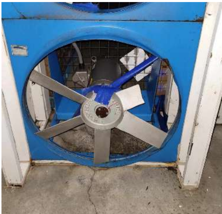
Figure 29. Broken Fan Blade
