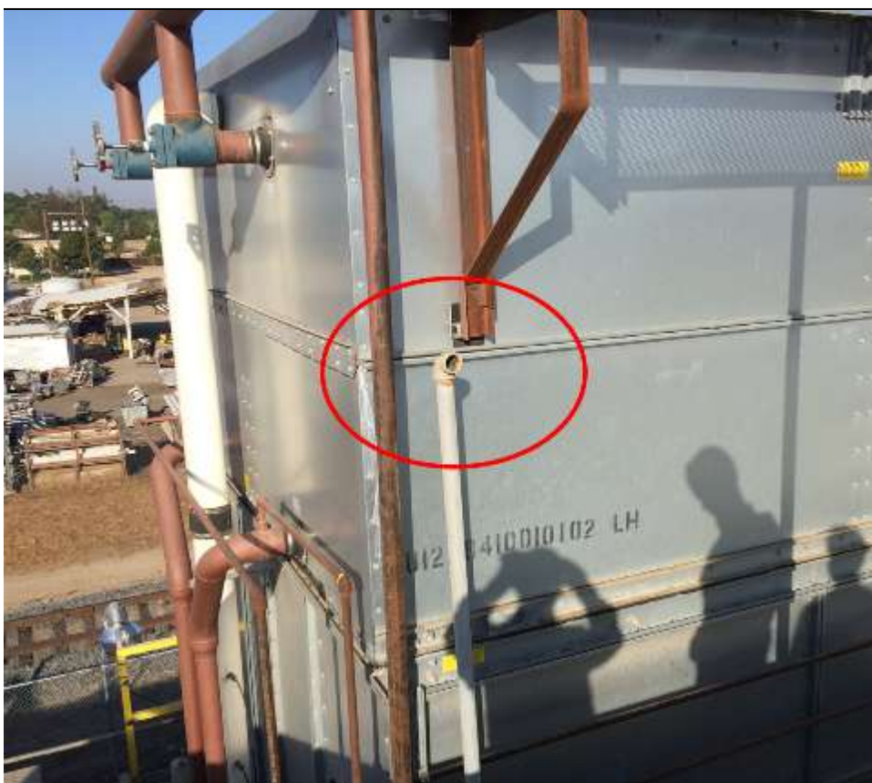
Figure 24. Relief Vent Discharge Pipe
