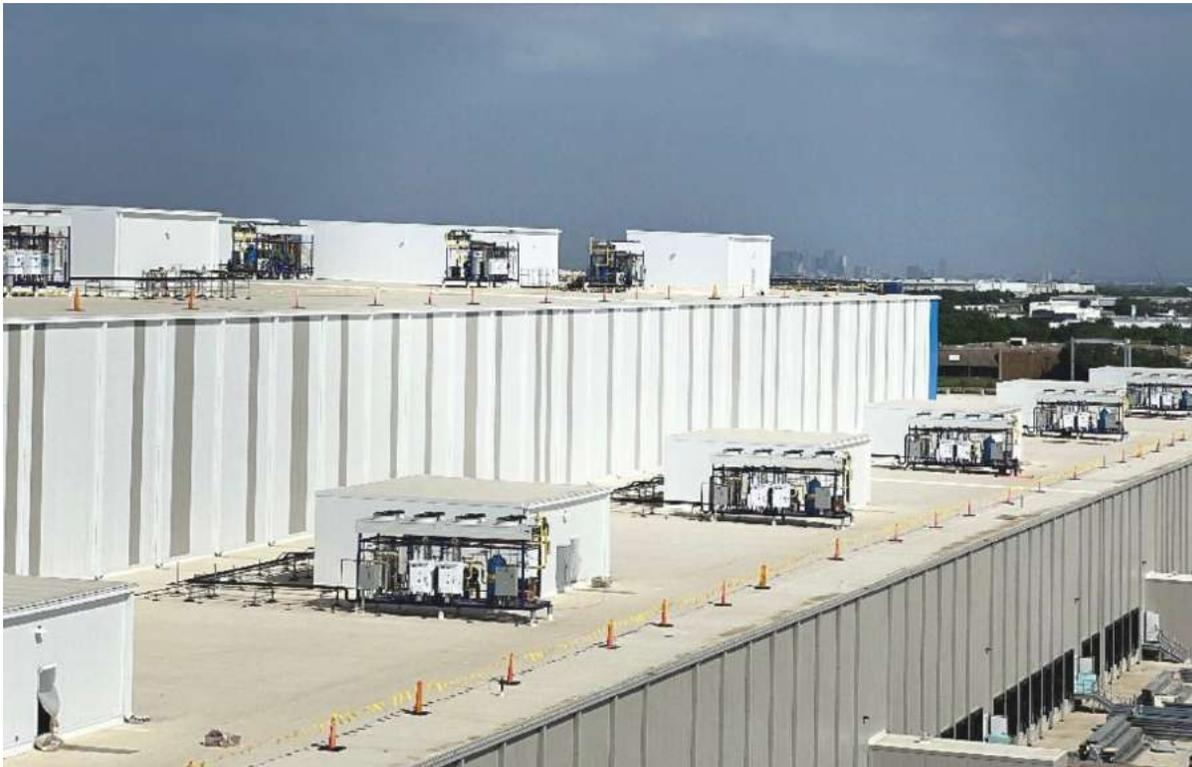
Figura 10. Paquetes DX de carga crítica de amoníaco en techo.
