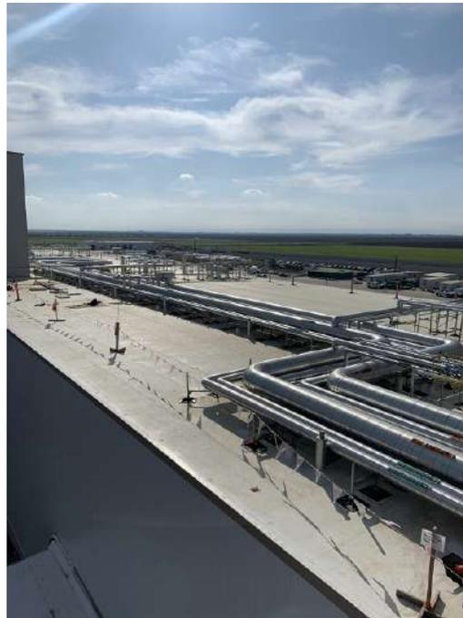
Figura 5. Red de Tuberías en techo de un sistema centralizado de amoníaco recirculado.
